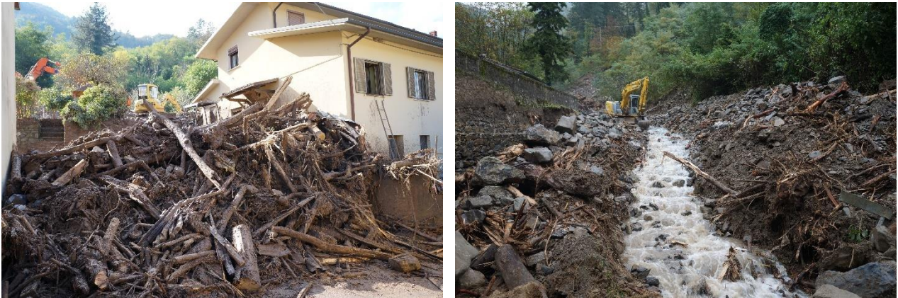
Figura 12 - Immagini relative a debris flow che hanno colpito Galliciano (21 ottobre 2013, in alto a sinistra), Fabbriche di Vergemoli Fosso della Meta (21 ottobre 2013, in alto a destra)
